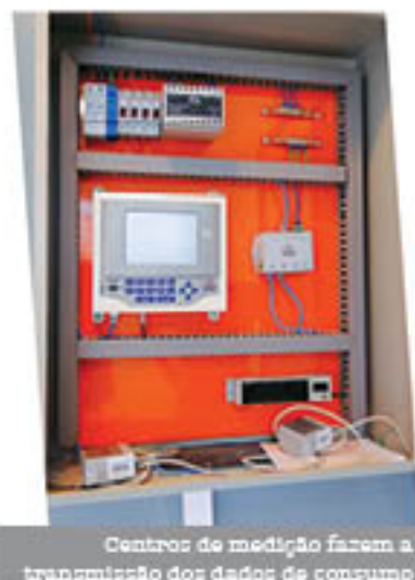
Medidores de água são instalados geralmente no hall dos andares
